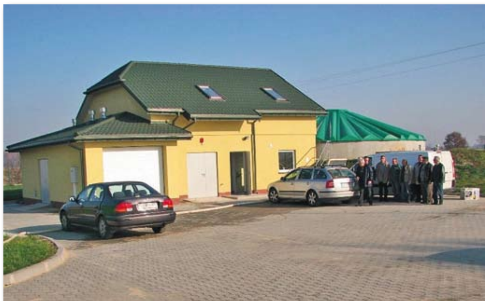
Oczyszczalnia ścieków w Zachorzowie
