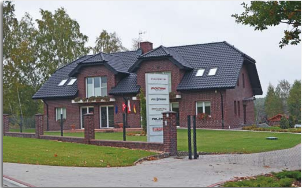
Siedziba firm POLTANK w Tomaszówku
