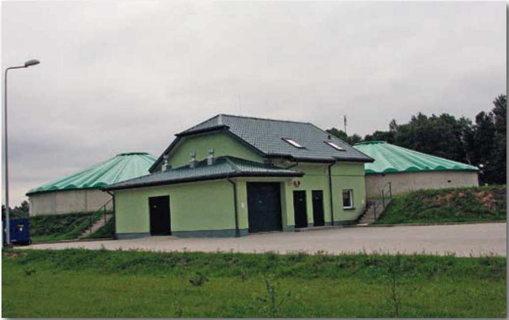
Oczyszczalnia ścieków w Trojanowie
